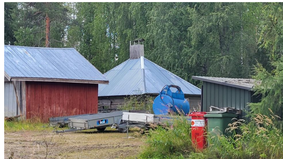
Kuva 59 Lähin RKY-kohde, Haapaniemen pyramidikattoinen kesänavetta, ei erotu maisemassa, sillä se sijaitsee lähes näkymättömissä pihan perällä tiheän puuston vieressä. Rakennuksen katto on uusittu peltiseksi, mikä on muuttanut rakennuksen olemusta.
