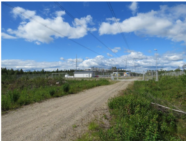
Kuva 64. Raatokankaan sähköasema kuvattu pohjoiseen.
