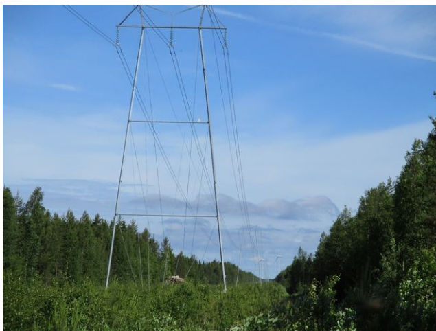
Kuva 18. Läntinen voimalinja Muhojoen kohdalla kuvattu pohjoiseen.
