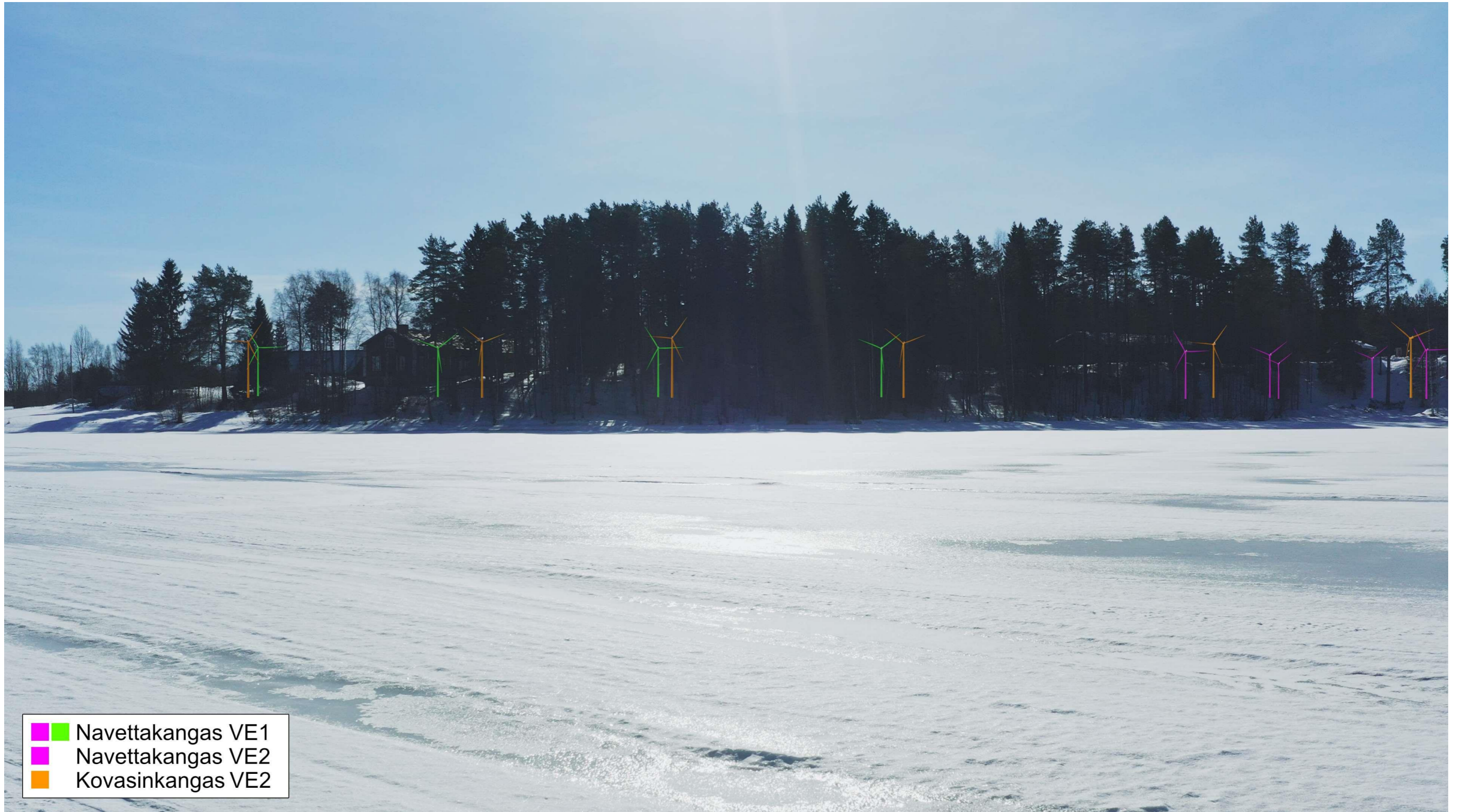
Kuva 35. Havainnekuva lijoen pohjoisrannalta Laurilanniemen kohdalta etelään kohti hankealuetta vaihtoehdosta VE1, mukana myös viereisen Kovasinkankaan hankkeen tuulivoimalat. Tuulivoimalat on korostettu eri väreillä vaihtoehdoittain ja hankkeittain.
