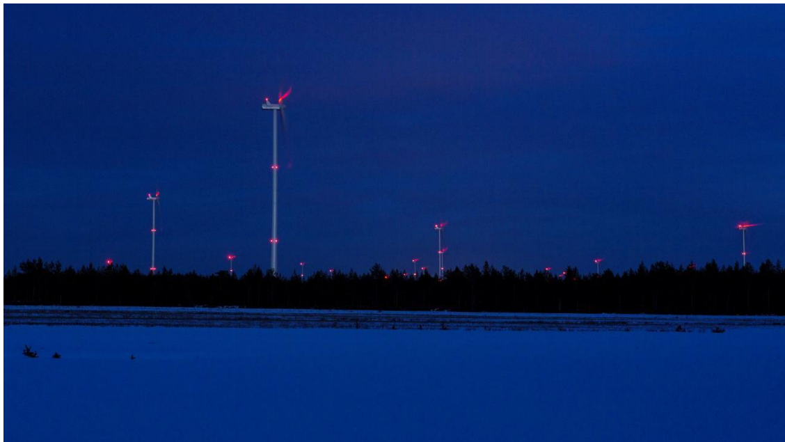
Kuva 70. Kiinteät punaiset lentoestevalot pimeällä. (Kuva: FCG)
