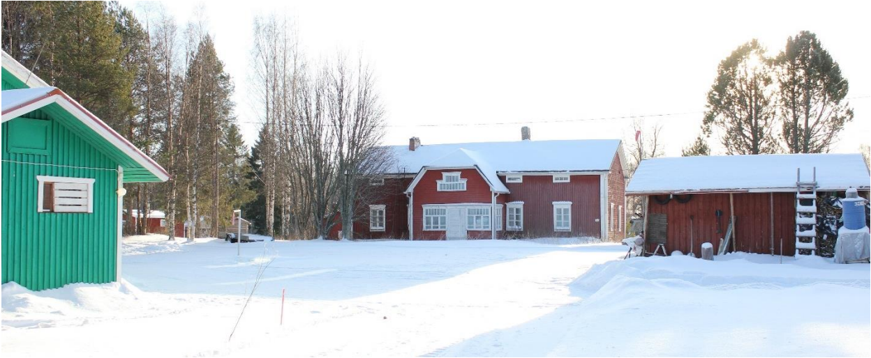
Ranta-Piukkulan asuinrakennus ja naapurikiinteistöllä sijaitsevia rakennuksia.
