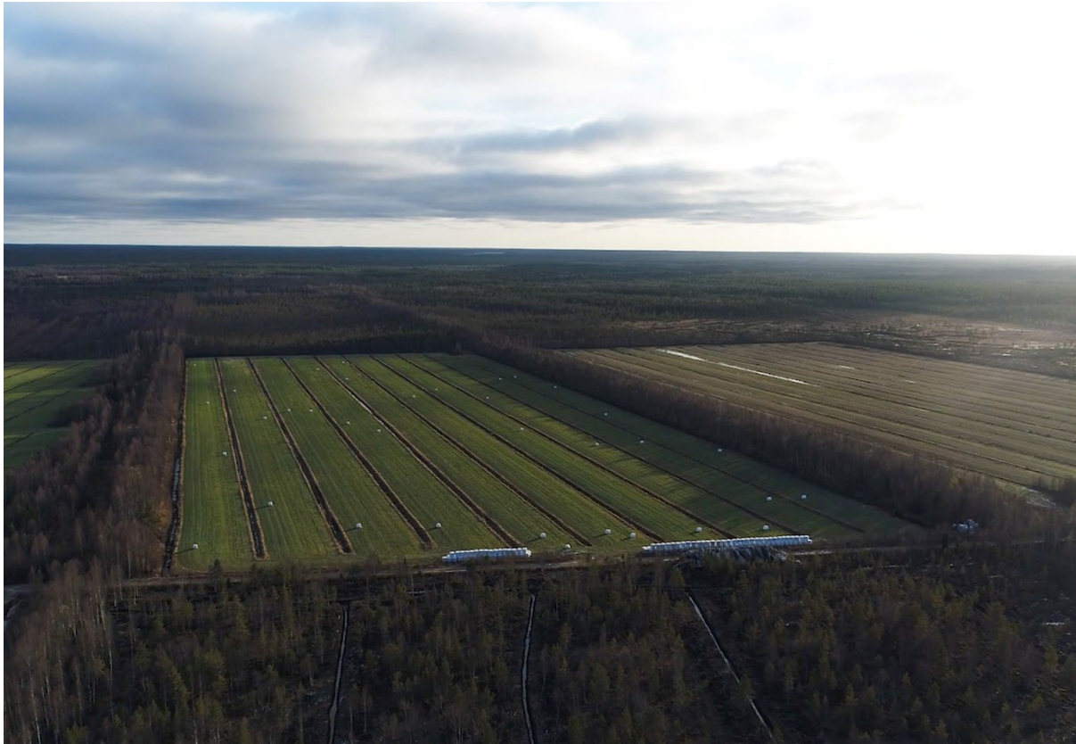
Kuva 12: Näkymä hankealueen eteläosasta kohti etelää (Arkkitehtitoimisto Ajak Oy).
