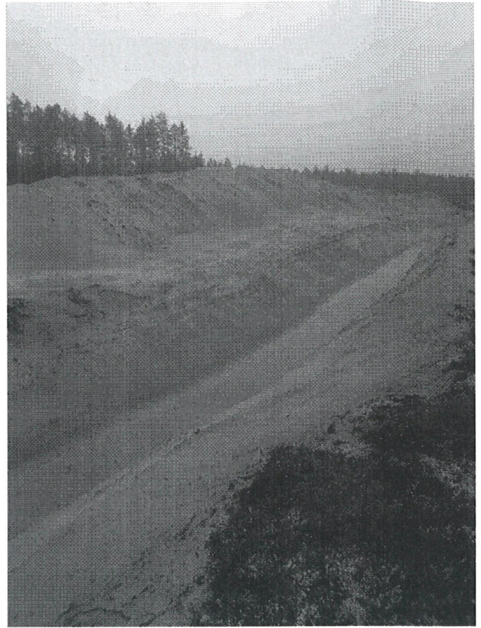
Kuva 2. Matkakankaalla oleva uusi syvä veto-oja, joka saa alkunsa kaivannon Meriänjärven puoleisesta päädyistä. Koko kangas on halkaistu kyseisellä ojalla.
