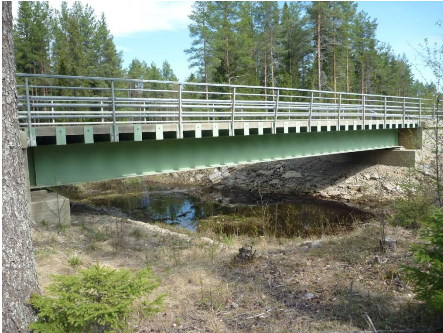
Kuva 20: Kantavuuden laskennallista varmentamista edellyttävä Olhavanjoen tulvahaaran silta Sahakoski II Konttilantiellä. 13
