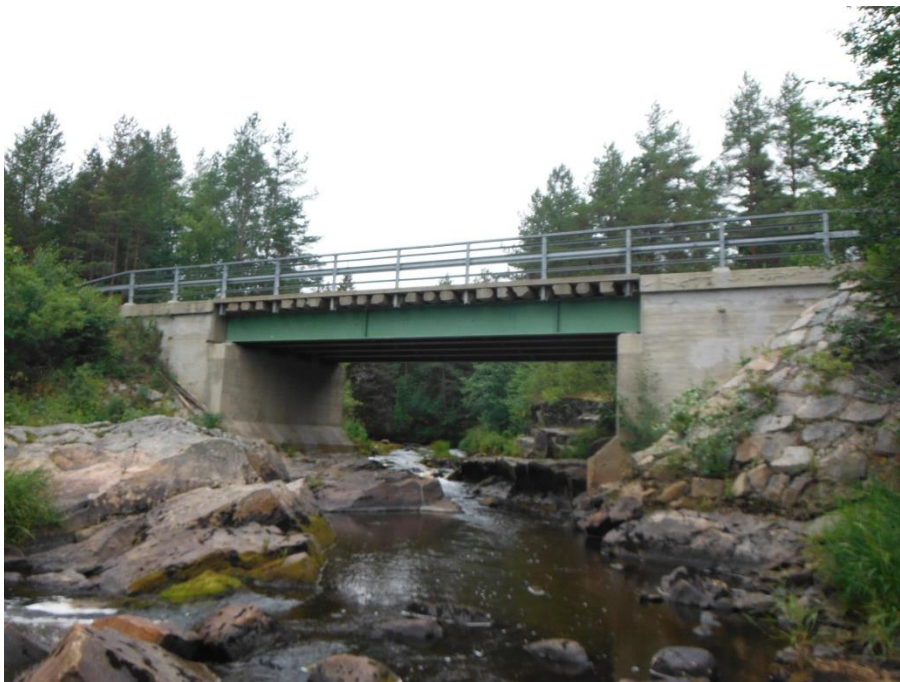
Kuva 20: Kantavuuden laskennallista varmentamista edellyttävä Olhavanjoen silta Sahakoski I Konttilantiellä. 14
